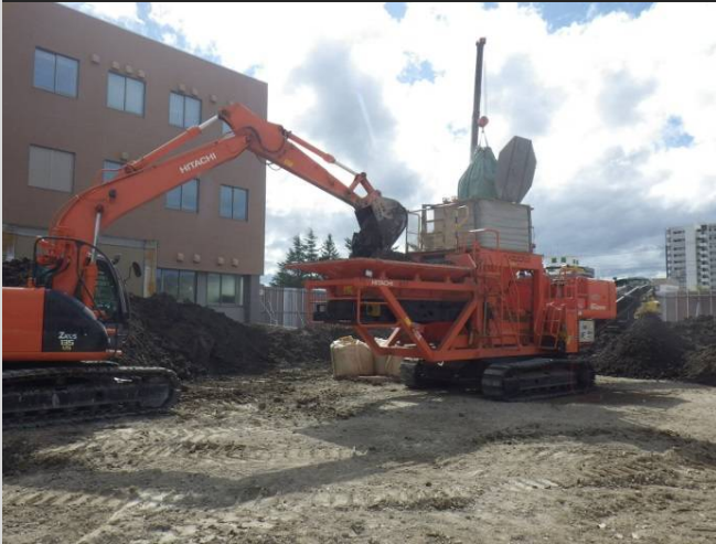
建設汚泥投入状況
