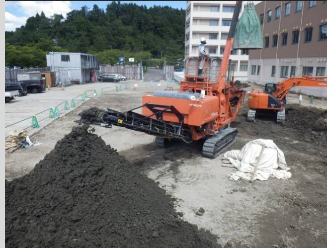
改良処理土排出状況
