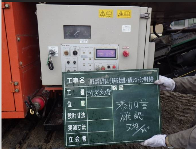
キャリブレーション (改良材添加量確認)
