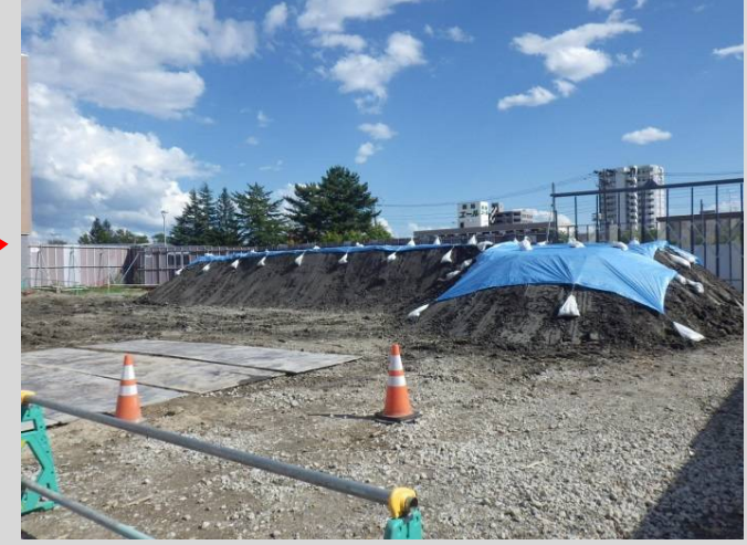
処理完了・整形養生⇒引渡し
