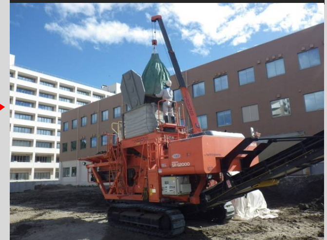
改良材 (DF剤2B号) 投入状況
