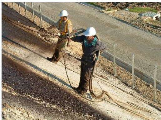
客土吹付状況
